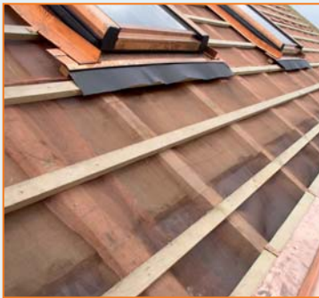
Steildach Festtackern der Bahnen auf und zwischen der Lattung
