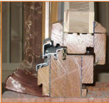
Fenster In Ziegelmeier-Fenster- rahmen mit Anbindung an die Wandfläche
