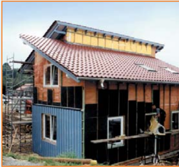
Holzständerbau Innenwände, Fassade und Dach
