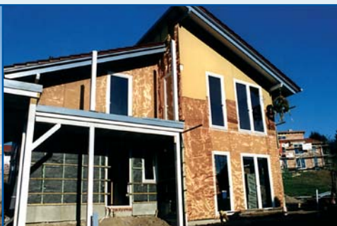
Holzständerhaus Neubau, Hameln
