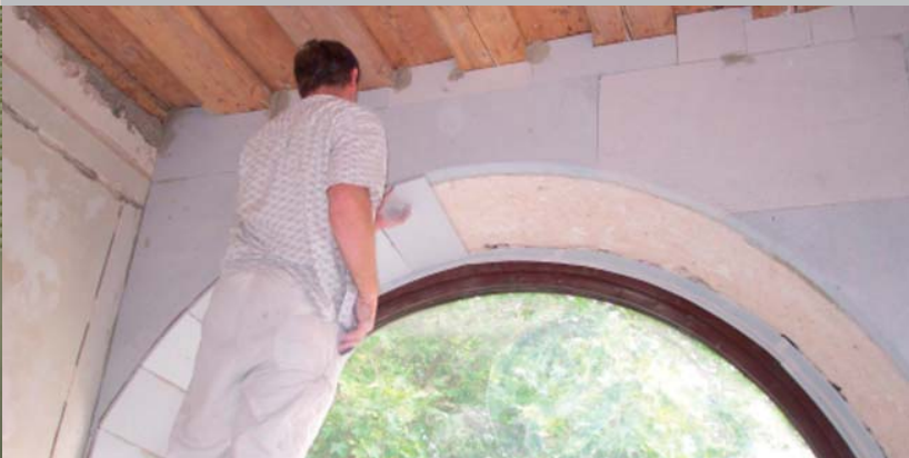
Rundbogen mit Laibungsplatten
