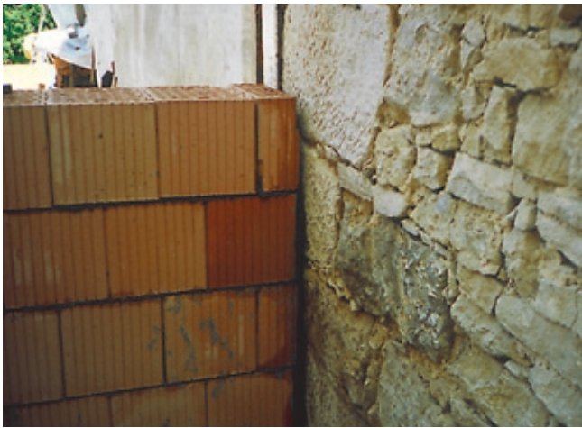
Mischmauerwerk, Backstein und Naturstein Maçonnerie mixte, briques et pierres taillées
