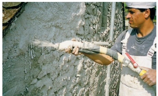
Maschinelles Aufspritzen von HAGATHERM® Application à la machine de HAGATHERM®
