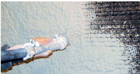
Auftragen von HAGA Bio-Grundputz als extra-harte Putzschicht. Auftragsstärke bis 15 mm möglich!
