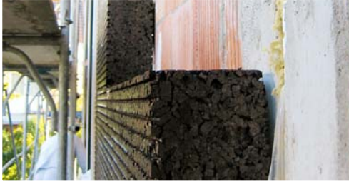
Versetzen und Anklopfen der Korit-Platten Pose et application des plaques Korit
