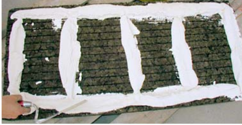
Aufbringen des HAGA Bio-Einbettmörtels Application du HAGA Bio-Einbettmörtel
