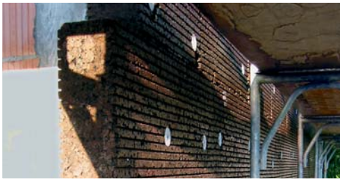
Je nach Objekt, Befestigung der Platten mit Dübeln Selon le type de situation, fixation des plaques à l'aide de chevilles
