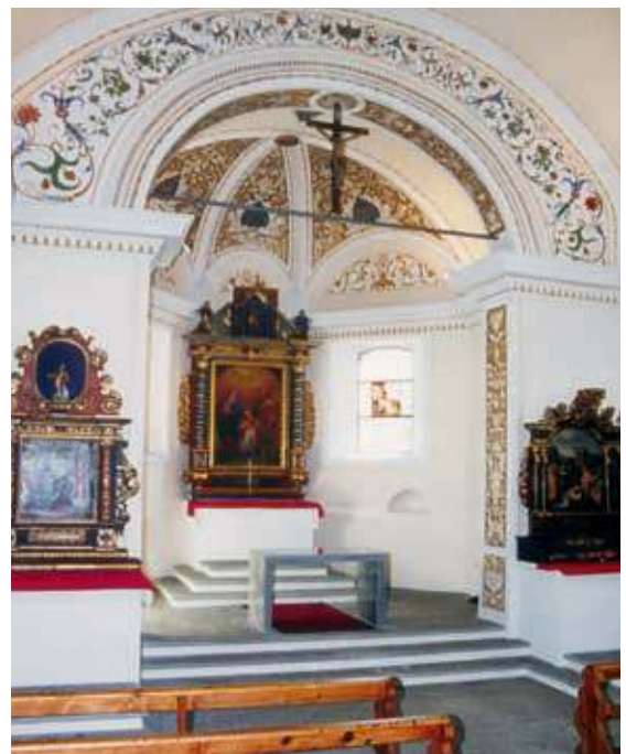
Thele Kapelle Leuk, Calkosit Sumpfkalkputz und Kalkfarbe
