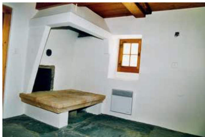
nach Sanierung mit Restaurierputz und Calkosit Sumpfkalkputz
