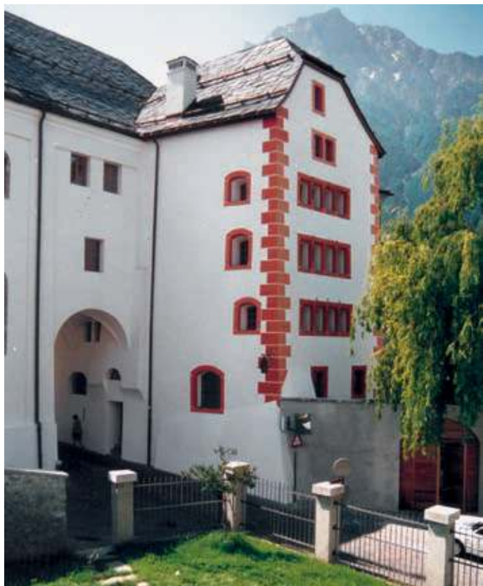
Kloster St. Ursula, Brig, HAGATHERM Wärmedämmputz und Calkosit Sumpfkalkputz aussen
