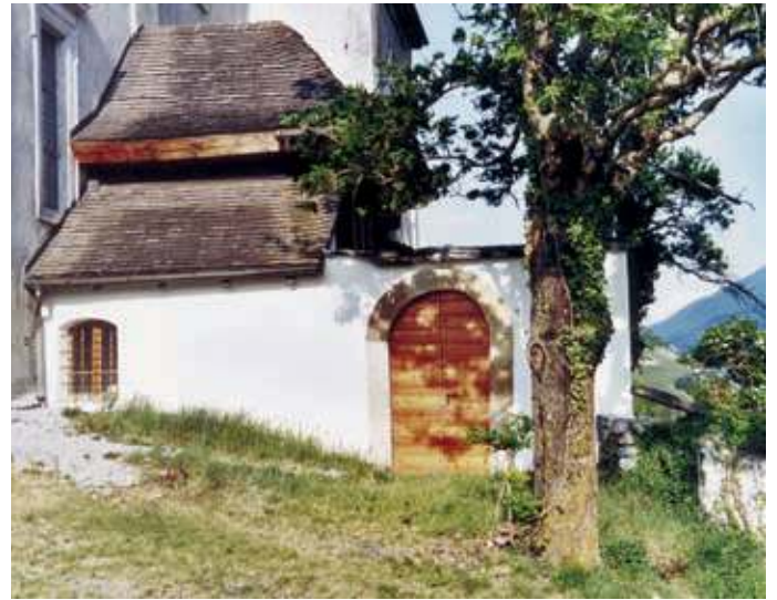
nach Renovation mit Restauriergrundputz und Calkosit
