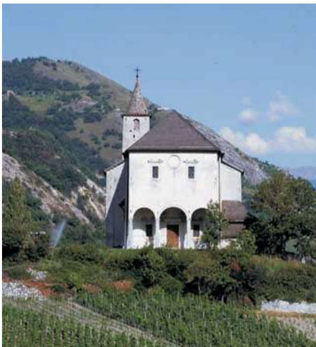
Ringackerkapelle, Leuk-Stadt, HAGA Sanierporenputz System
