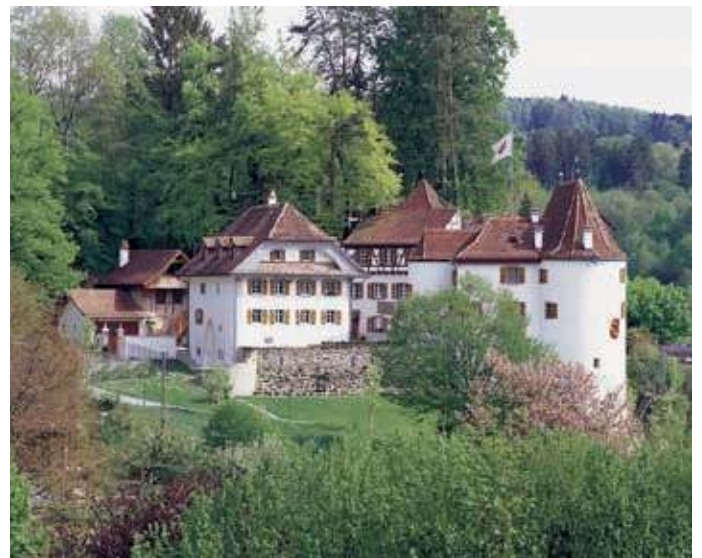
Trostburg Teufenthal, Rezepturmörtel nach Denkmalpflege, Calkosit Sumpfkalkputz und Kalkfarbe
