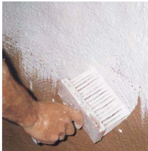
HAGA Sumpfkalkfarbe kann in der Fresko-Technik frisch in den Restaurierputz verarbeitet werden.
