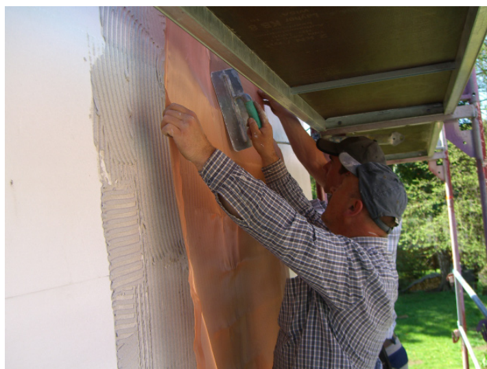
Einspachteln von Cuprotect® an Fassade.
