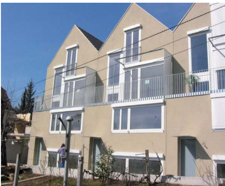
Neubau mit Kork Wärmedämm-Verbundsystem mit rein mineralischem Verputz.
