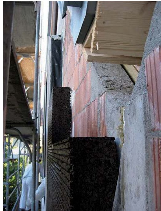
Wärmedämmung an Alt- und Neubau.
