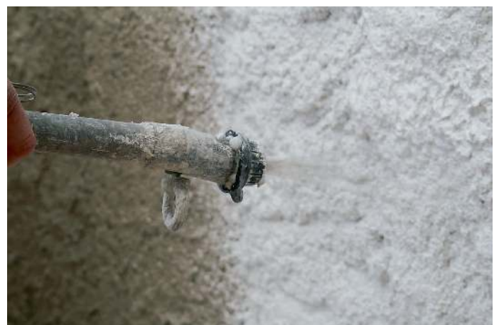
Bei grösseren Flächen wird maschinell gearbeitet.
