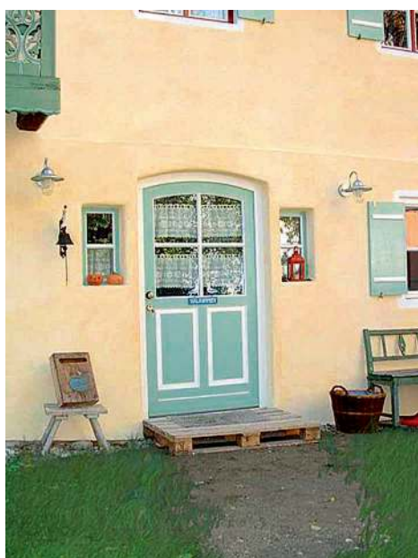
Mit HAGA Biotherm® sanierte „alt“ Hausfassade.
