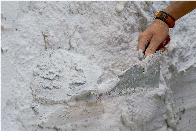
Der extrem leichte HAGA Biotherm®-Mörtel kann von Hand an die Wand geworfen werden.
