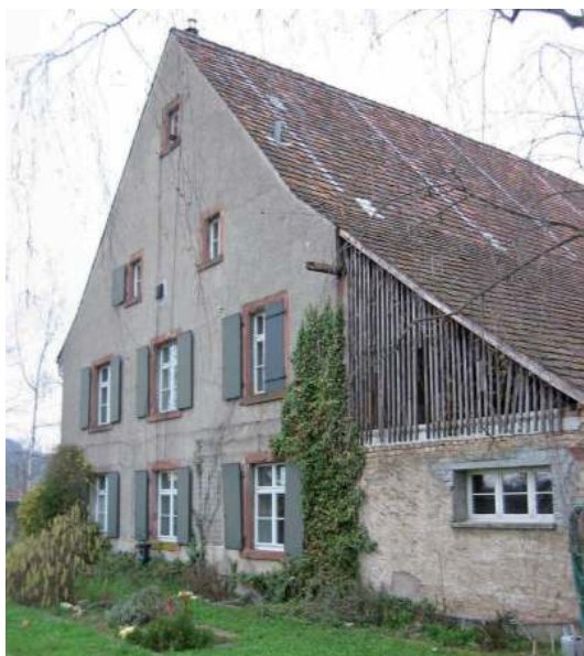
Vor der Fassaden-Renovation mit HAGA Biotherm®.
