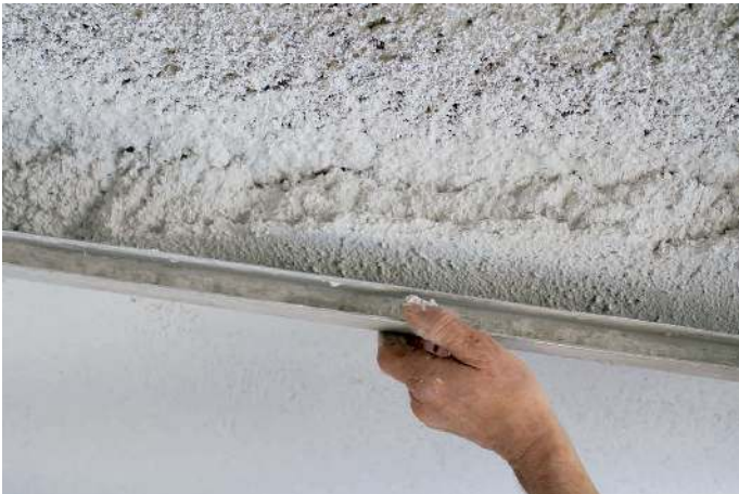
Glatziehen des Putzes.
