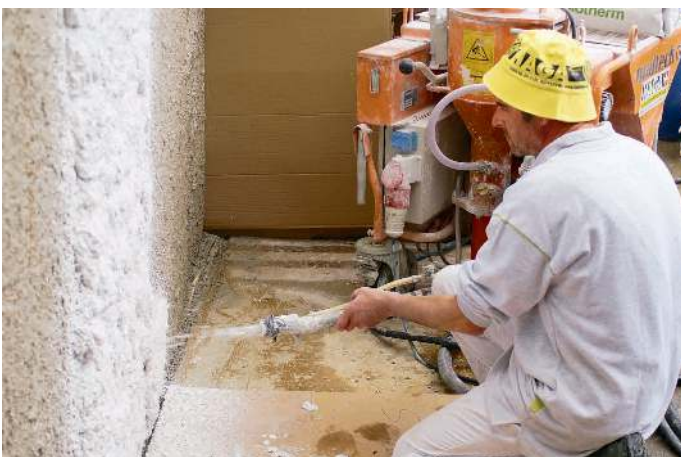
HAGA Biotherm® maschinell aufgespritzt und verarbeitet.
