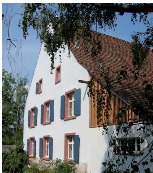
Nach der Fassaden-Renovation mit HAGA Biotherm®.
