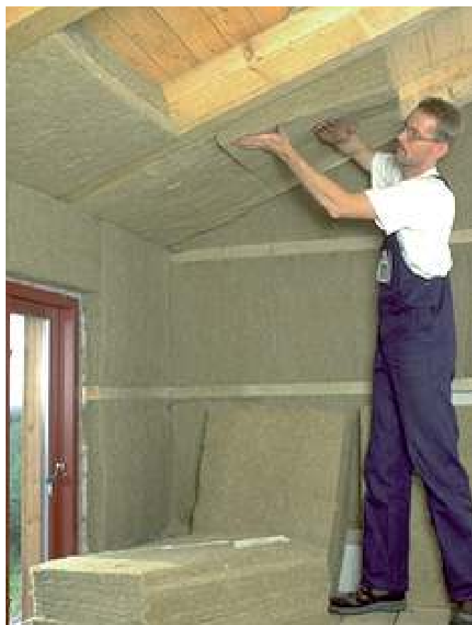
Isolation aus reinem Flachs als Wärmedämmung
