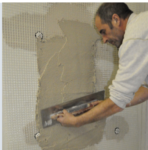
2 HAGA Biotherm oder Bio-Grundputz mit Traufel oder maschinell mind. 10 mm auftragen.
