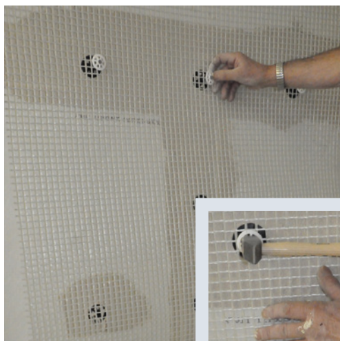
1 HAGA Stützgewebe, HAGA Drahtgitter als Putzträger mit Distanzhalterdübel fixieren.
