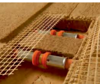
Verbindung der Platten durch Presskupplungen
