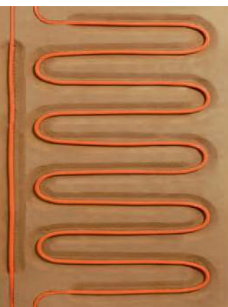
Innenleben einer naturbo therm Zwischenplatte
