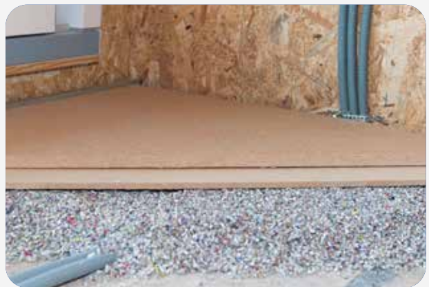
THERMOFLOC-Dämmpellets als druckbelastbares Zellulosegranulat
