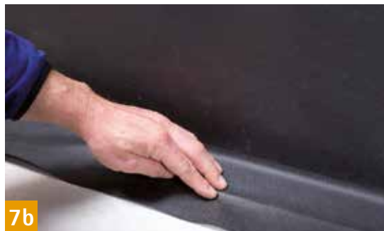
ORCON F Allround-Anschlusskleber in Kartusche oder Schlauchfolie. Für Verbindungen an angrenzende mineralische oder raue Bauteile.
