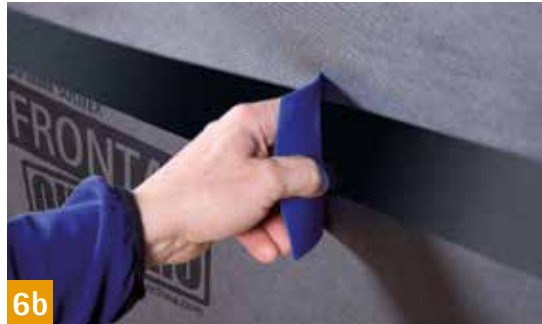
TESCON INVIS Allround-Klebeband zur Verklebung der Bahnenüberlappungen
