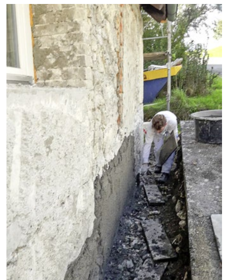
Sockeldämmung mit HAGATHERM Sockelputz mit Schaumglas
